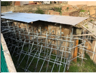
Muro di età basso medievale con puntellatura di messa in sicurezza provvisoria (lato esterno)
